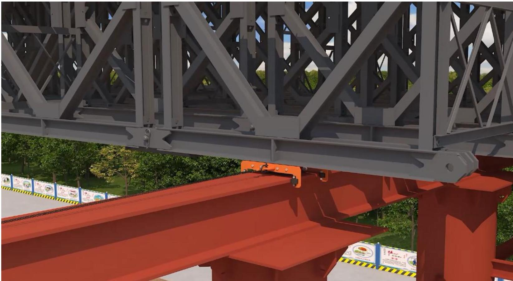
为了提高桁架的使用效率，由浙江兴土桥梁专用装备制造有限公司研发、制造坦克小车，进行桁架拆除阶段的整体横移
